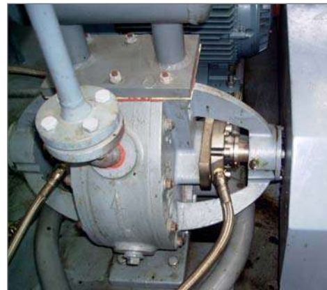
Adaptación de sello técnico en molino de emulsión asfáltica
